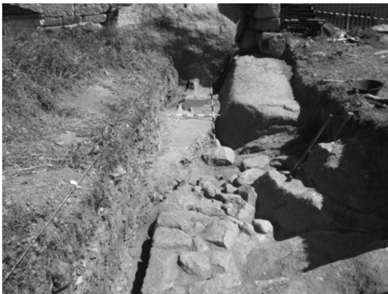
Imagen 37: Lecho de hormigón del muro de cerramiento de la antena de repetición asentado sobre los restos de la cortina norte
